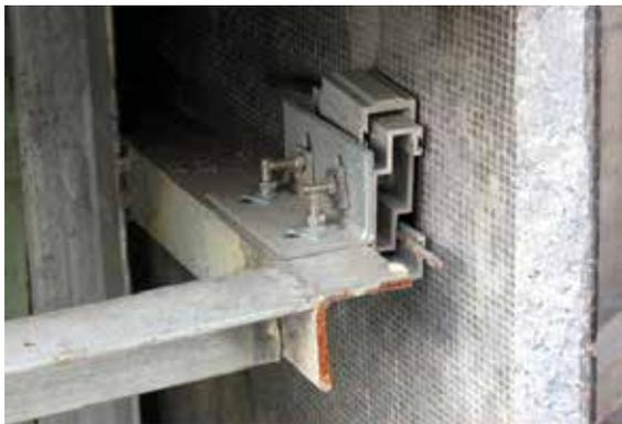
如上图，由于背栓孔所打的位置偏差较大，在石材安装完毕调整好缝隙后，还是出现个别的背栓转接金属挂件不能够充分接触挂接。
