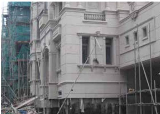
e. 在建筑产品中往往我们会遇到将石材板块加工成各种造型的线条板(上图)为了凸出采光窗而出现的窗侧板,线条板一般都是在加工厂加工成形,板块规格一般比较大带来自重都比较大,而且水平龙骨安装交叉严重等因此不宜于使用背栓体系,窗侧板特别是窗上下部位收口板,在实际施工中由于板块规格一般较小用背栓体系比较不利于操作;
