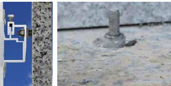
如上图，由于背栓孔所打的深度偏差较大，造成背栓不能够完全置入孔内，在背栓与金属转接件连接固定后就会出现如图的缝隙存在，从而使石材不能够与金属转接件充分面接触，使背栓不但承受剪力同时还承受弯矩力。
